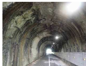
図-2 覆工全体状況
