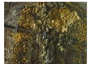
図-3 黄褐色変色箇所
