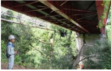
写真-2 UAVによる桁下の撮影
