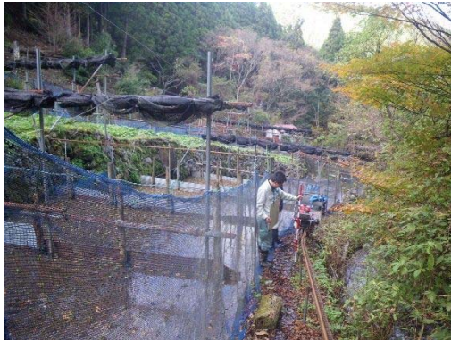
図 3-1 既設レールの調査
