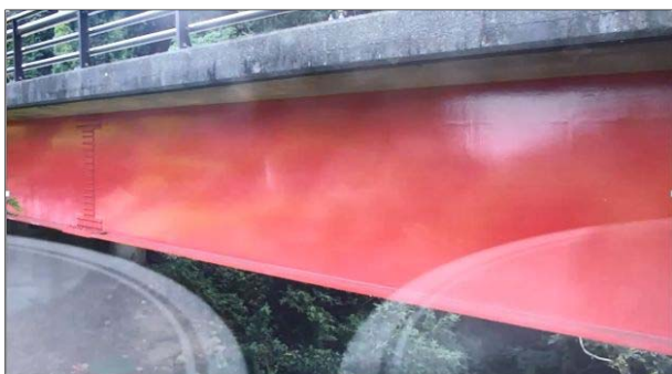
通常撮影が困難な橋梁全体の動画撮影
