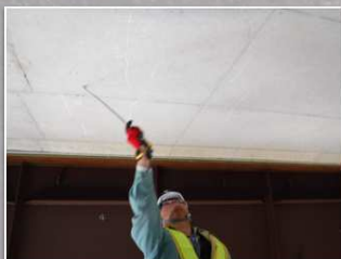
調査箇所（静岡県伊豆市）
