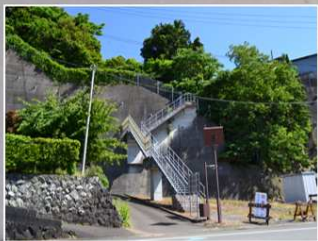
設置状況（静岡県沼津市）
