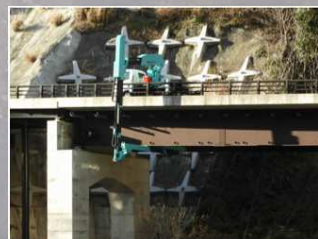
調査箇所（静岡県伊豆市）
