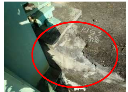
写真 3-6 P1 橋脚補修形跡
