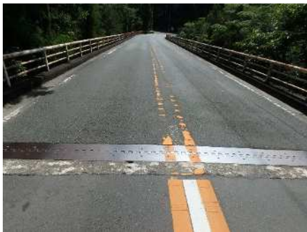
写真 4-1 伸縮装置遠景
