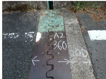
写真 4-2 伸縮装置近景
