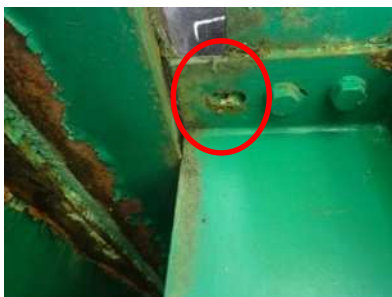
写真 3-4 P1 橋脚主桁上部
