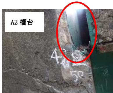
写真 3-5 A2 橋台遊間部
