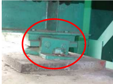
写真 3-2 支承の変形
