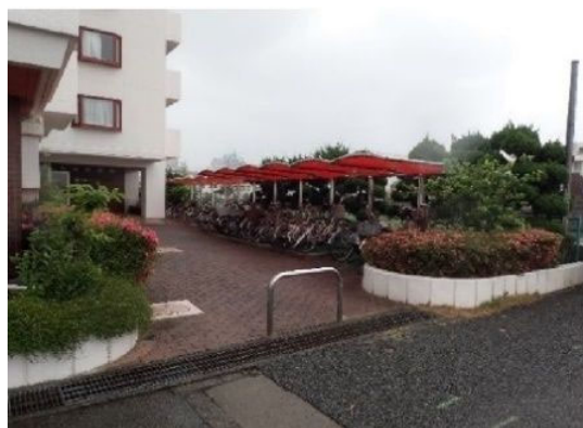
写真-5.1 マンション入口
