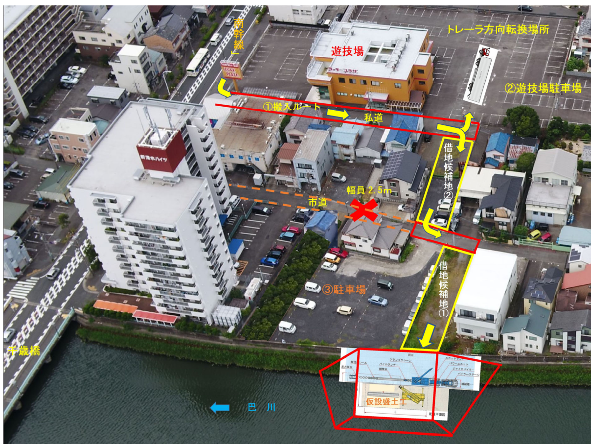
図-5.4 重機や資材の進入路
