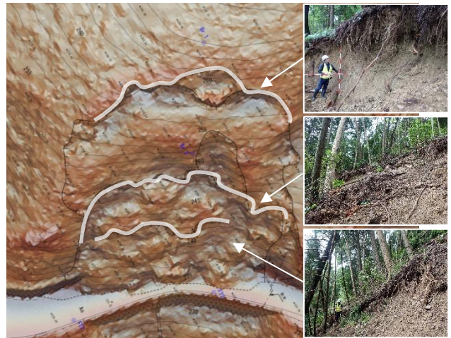
図-7 地形起伏及び崩落崖状況
