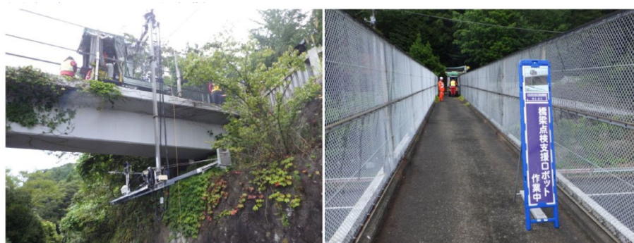
写真－8 橋梁点検カメラシステム現場写真 2
