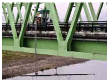
写真-19 トラス橋
