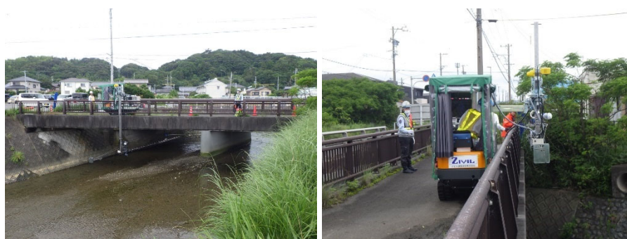
写真-12 橋梁点検カメラシステム現場写真 6
