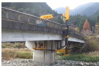
写真-1 橋梁点検車
