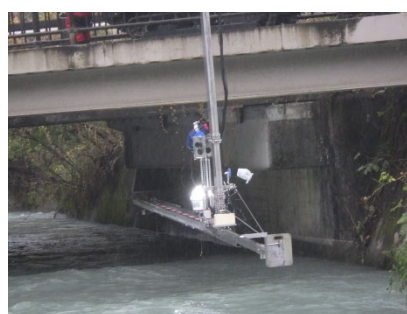
写真-16 橋梁桁下状況写真
