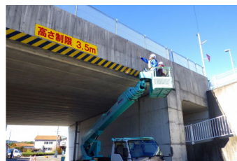
写真-2 高所作業車
