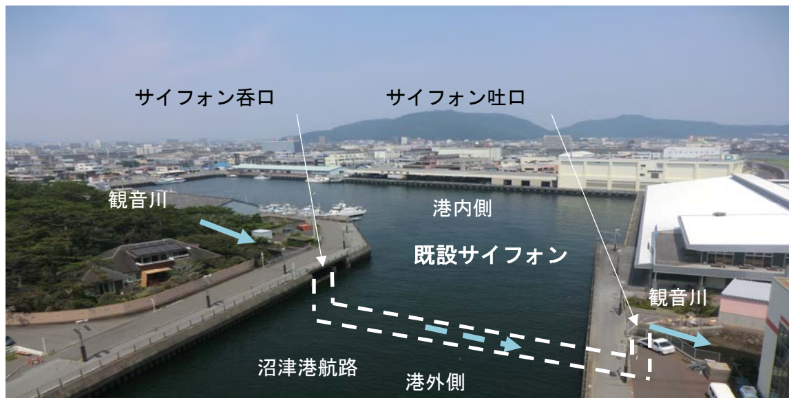
写真-2.1 観音川サイフォン部の全景
