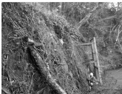
道路下の土留壁に変状はない
