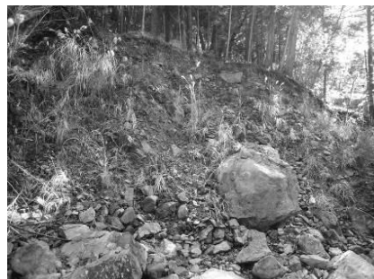
道路の下方斜面末端部の河川浸食による崩壊地形
