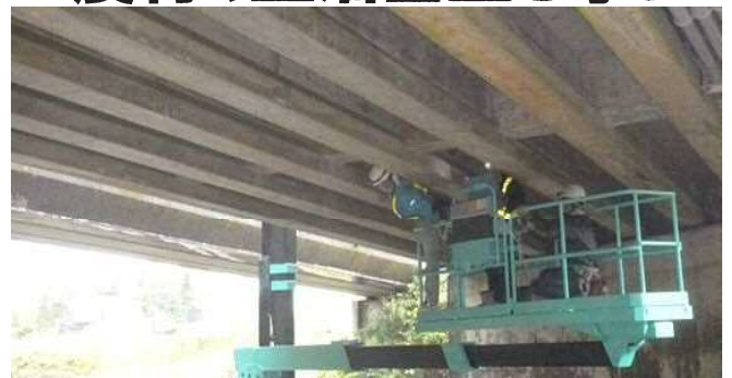
広域農道・橋梁の点検・補修
