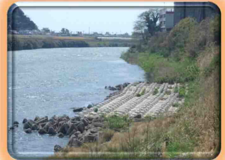
沈床工（深掘対策）
