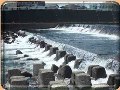
用水堰修繕（機能回復）
