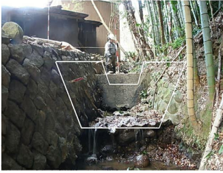
既設流路工底張破損状況
