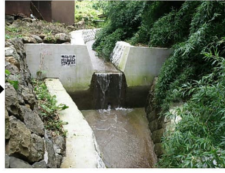
工事完成状況
