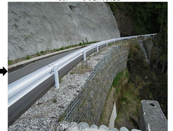
復旧工事完成状況
