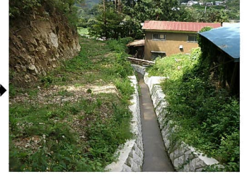
工事完成状況
