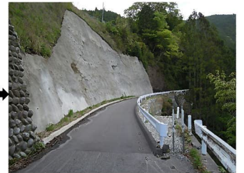
復旧工事完成状況
