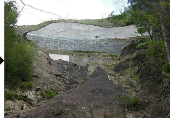
復旧工事完成状況
