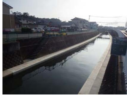
鋼矢板護岸工施工計画を立案するにあたり、計画箇所が住宅密集地のため、無振動タイプのサイレントパイラーを選定し、橋梁下は架空制約があるため、上部障害クリア工法を選定した。
