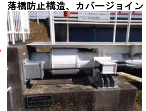
施工後 落橋防止構造
