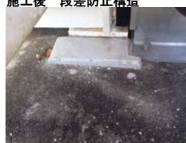
施工後 段差防止構造
