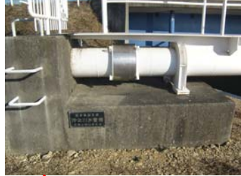
施工後 落橋防止構造（橋軸直角方向）
