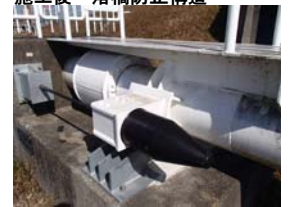
施工後 落橋防止構造
