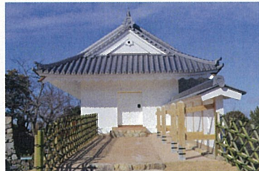
櫓の出入り口前に杭を設置
