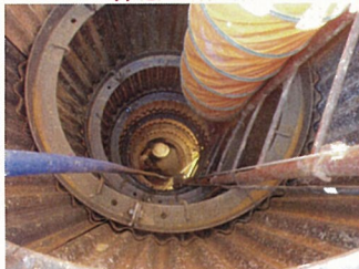
人力で掘削した基礎杭の孔
