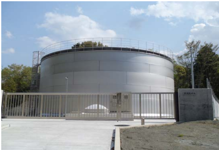
牧之原市 新配水池<完成予想図> SUS製円形鋼板構造 1,500m 3 × 2池
