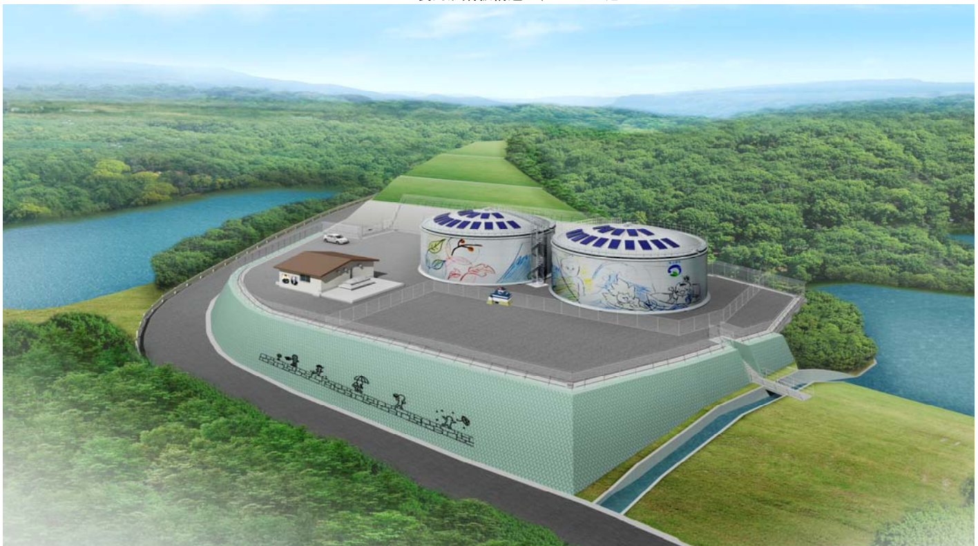
牧之原市 新配水池<完成予想図> SUS製円形鋼板構造 1,500m 3 × 2池
