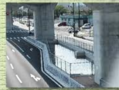
雨水流出抑制対策 高架橋下中央分離帯の活用
