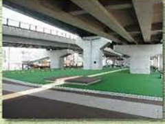
人工芝の敷設により、人に優しい多目的広場として活用
